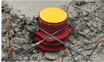
Betonieren und rütteln
