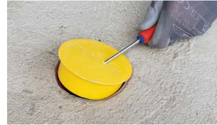
Bauschutzdeckel entfernen
