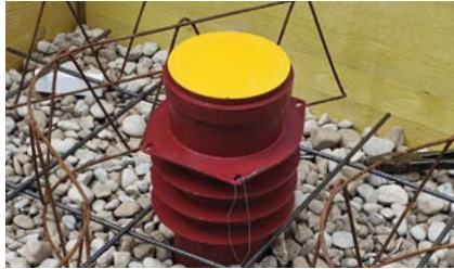
Einrichten auf Oberkante Fundamentplatte
