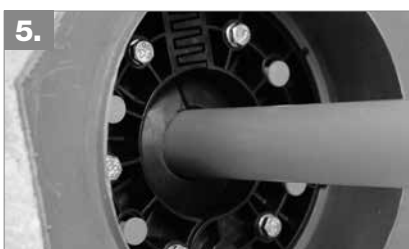
Dichtelement DN 150: Sobald alle gelben Verpressindikatoren aus dem Flansch herausgedrückt sind, Schrauben mittels Drehmomentschlüssel auf 6 Nm anziehen.
