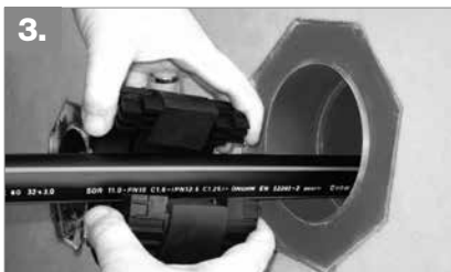
3. Dichtelement über die Mediumleitungen klappen und bis zur Anschlagkante ins Lamellenrohr schieben. Alternativ dazu können beide Dichtelemente von innen eingeschoben werden.
