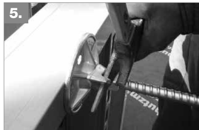
5. Zweite Schalungswand aufstellen, Schalungsanker anziehen.
