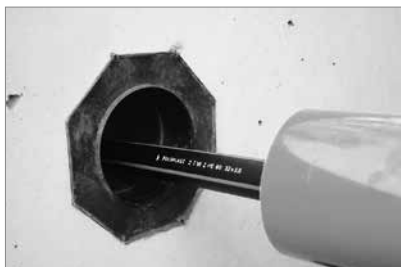
Mediumleitung durch das Setzungsschutzrohr und das Lamellenrohr schieben.
