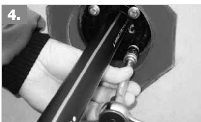
Schrauben in mehreren Durchgängen über Kreuz anziehen. Beginnen Sie bei einem der Schrauben am Teilungsmechanismus. Mehrfach-Dichtelement DN 150: Beginnen Sie mit den zwei Schrauben in der Mitte. Anschließend die Schrauben mit Drehmomentschlüssel auf 6 Nm anziehen.
