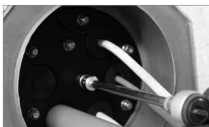
Schrauben in mehreren Durchgängen über Kreuz anziehen. Beginnen Sie bei einem der Schrauben am Teilungsmechanismus. Mehrfach-Dichtelement DN 150: Beginnen Sie mit den zwei Schrauben in der Mitte. Anschließend die Schrauben mit Drehmomentschlüssel auf 6 Nm anziehen.
