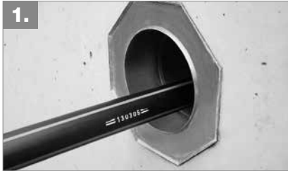
1. Mediumleitung durch das einbetonierte Lamellenrohr schieben.
