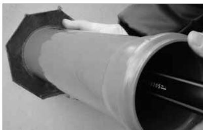
Setzungsschutzrohr in das Lamellenrohr einstecken.
