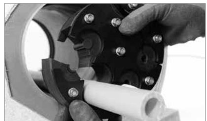
3. Dichtelement über die Mediumleitungen klappen und bis zur Anschlagkante ins Lamellenrohr schieben. Alternativ dazu können beide Dichtelemente von innen eingeschoben werden.
