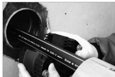
Dichtelement über die Mediumleitung klappen und bis zum Anschlag in das Lamellenrohr einschieben.
