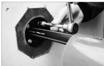
Schrauben in mehreren Durchgängen über Kreuz anziehen – Anzugsmoment 6 Nm.
