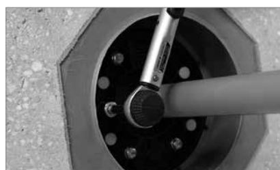
Dichtelement DN 150: Sobald alle gelben Verpressindikatoren aus dem Flansch herausgedrückt sind, Schrauben mittels Drehmomentschlüssel auf 6 Nm anziehen.
