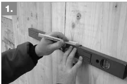
1. Lage der Rohrachse an der Schalungswand anzeichnen.
