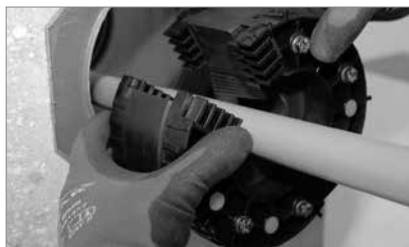
3. Dichtelement über die Mediumleitungen klappen und bis zur Anschlagkante ins Lamellenrohr schieben. Alternativ dazu können beide Dichtelemente von innen eingeschoben werden.
