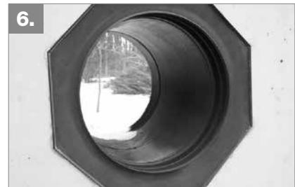
6. POLO-RDS evolution Lamellenrohr fertig einbetoniert.
