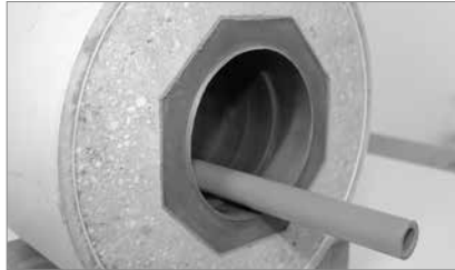
1. Mediumleitung durch das einbetonierte Lamellenrohr schieben.
