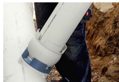
15. Rohranschluss herstellen: DN 200 +/- 8°; Bogen bis 45°.
