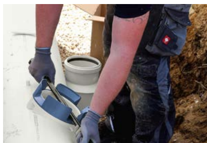
10. Durch 90° Drehung festziehen
