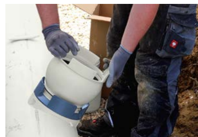
12. Kugel DN 200 von Hand anziehen.
