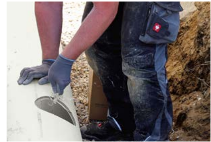
3. Bohrloch innen und außen entgraten.
