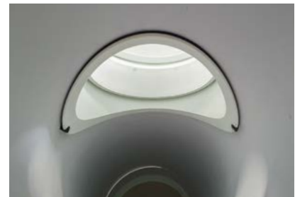
9. Innenflansch auf korrekten Sitz prüfen (Tastprüfung).
