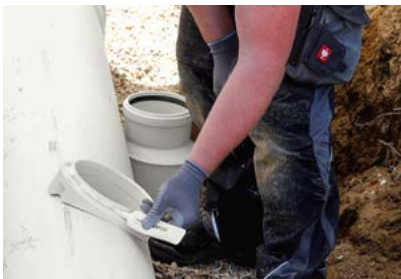
7. Gleitmittel auf Gewinde auftragen.
