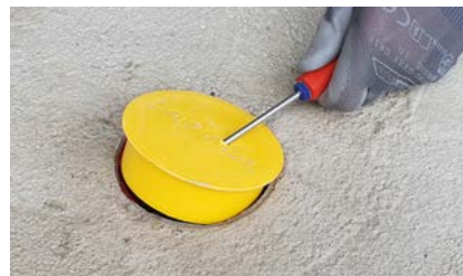
Bauschutzdeckel entfernen
