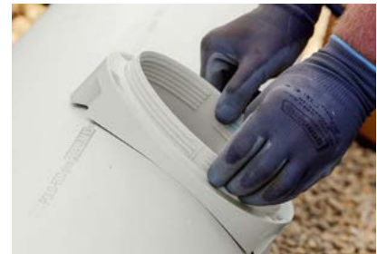
6. Ausgleichsring durch Einrasten fixieren.
