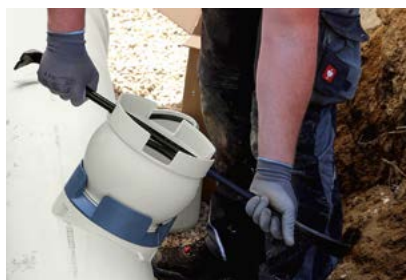
13. Kugel DN 200 festziehen.
