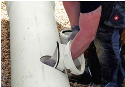
4. Innenflansch in das Bohrloch einsetzen.
