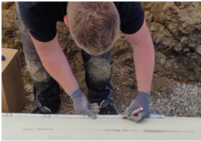
1. Rohr reinigen, messen und anzeichnen.
