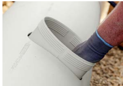
5. Innenflansch korrekt positionieren.
