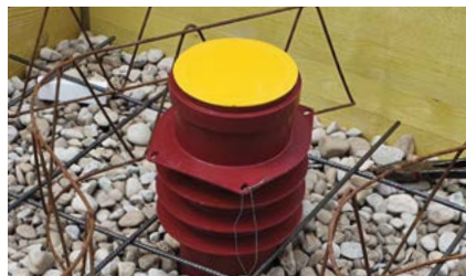
Einrichten auf Oberkante Fundamentplatte
