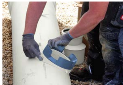
8. Mit Finger zentrieren und festziehen.
