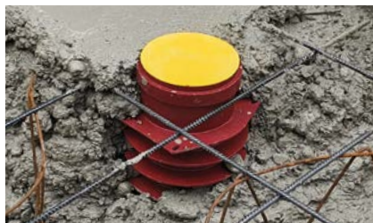
Betonieren und rütteln
