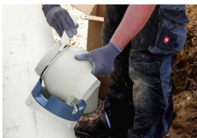
11. Gleitmittel auf Gewinde auftragen.
