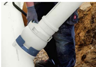
14. Rohranschluss herstellen: DN 160 +/- 6°.
