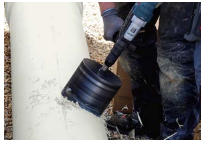
2. Radial in einem Winkel von 90^\circ mit Lochsäge anbohren (0/+1 mm).
