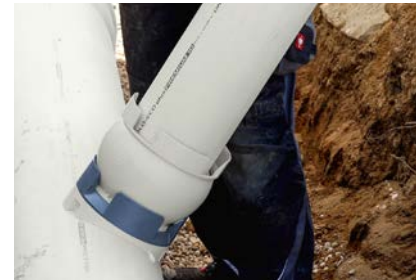
15. Rohranschluss herstellen: DN 200 +/- 8°; Bogen bis 45°.
