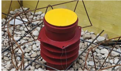
Einrichten auf Oberkante Fundamentplatte
