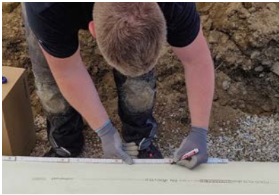
1. Rohr reinigen, messen und anzeichnen.
