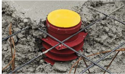
Betonieren und rütteln
