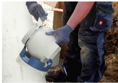
11. Gleitmittel auf Gewinde auftragen.
