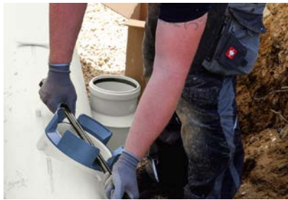
10. Durch 90° Drehung festziehen
