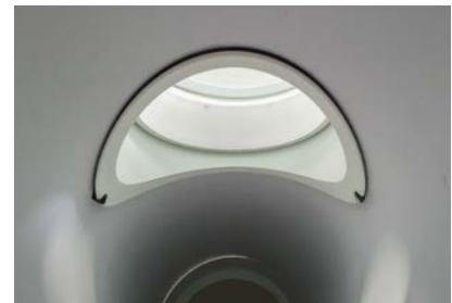
9. Innenflansch auf korrekten Sitz prüfen (Tastprüfung).
