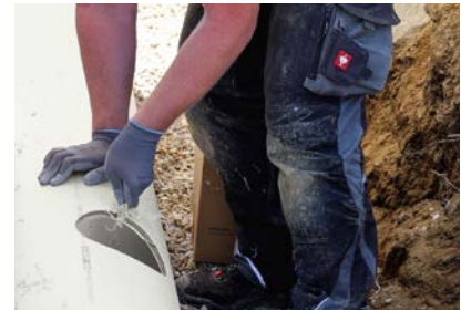
3. Bohrloch innen und außen entgraten.
