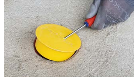
Bauschutzdeckel entfernen
