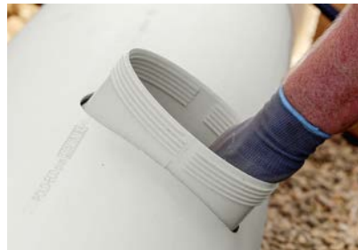
5. Innenflansch korrekt positionieren.
