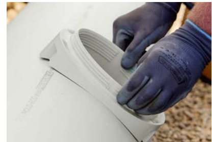
6. Ausgleichsring durch Einrasten fixieren.
