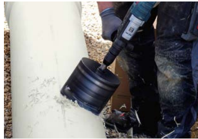
2. Radial in einem Winkel von 90^\circ mit Bohrkronen anbohren (0/+1 mm).
