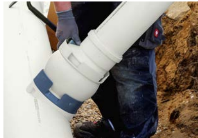
14. Rohranschluss herstellen: DN 160 +/- 6°.
