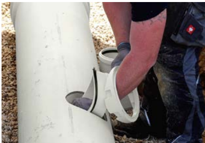
4. Innenflansch in das Bohrloch einsetzen.
