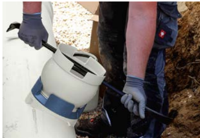
13. Kugel DN 200 festziehen.
