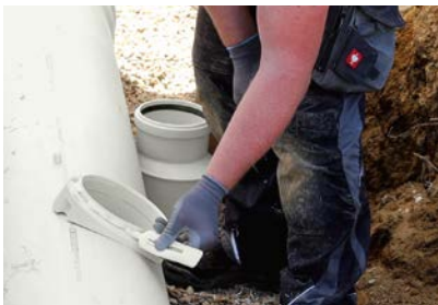
7. Gleitmittel auf Gewinde auftragen.
