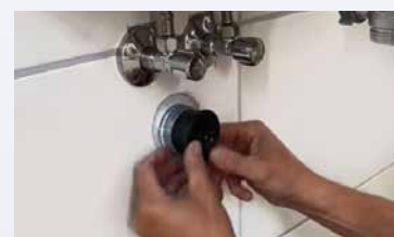
Anbringen des Siphongummis
