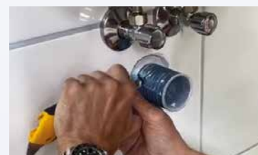
Leichteres Kürzen durch das vorgeprägte Siphonrohr mit einem Cutter
