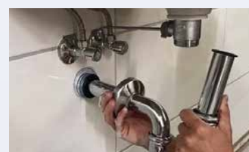
Montage Röhrensiphon
